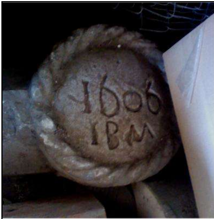
Clef de voûte
