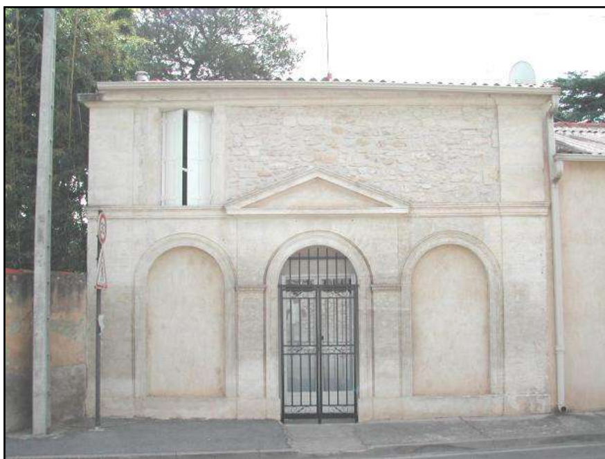
La serre du château devenue une maison après modifications.
